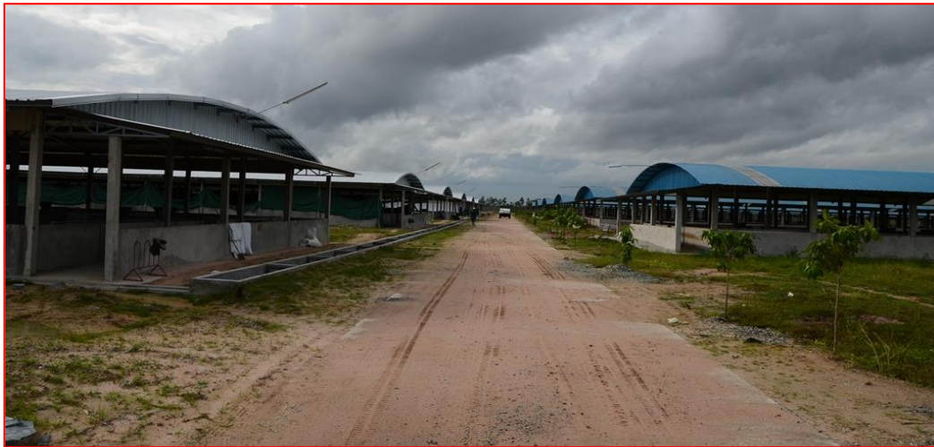
រូបទី១.៩ : ការធ្វើប្រឡាយប្រមូលផ្តុំកាកសំណល់ ទឹកស្អុយដើម្បីកាត់បន្ថយបញ្ហាក្លិនស្អុយ រុយដែលជា ភ្នាក់ងារចម្លងជំងឺ និងជាប្រព័ន្ធគ្រប់គ្រងកាកសំណល់ក្នុងបរិវេណទ្រុងជ្រូក។
